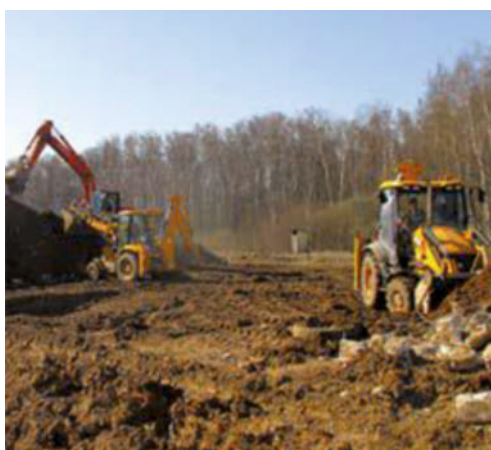
Рытье котлованов, земляные работы
