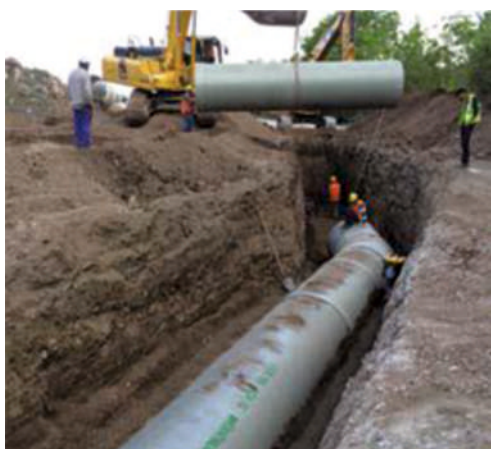
Укладка трубопроводов
