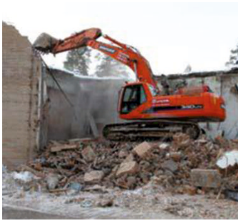
Демонтаж зданий и сооружений
