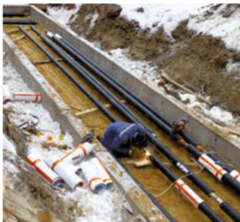
Ремонт наружных сетей водопровода и канализации
